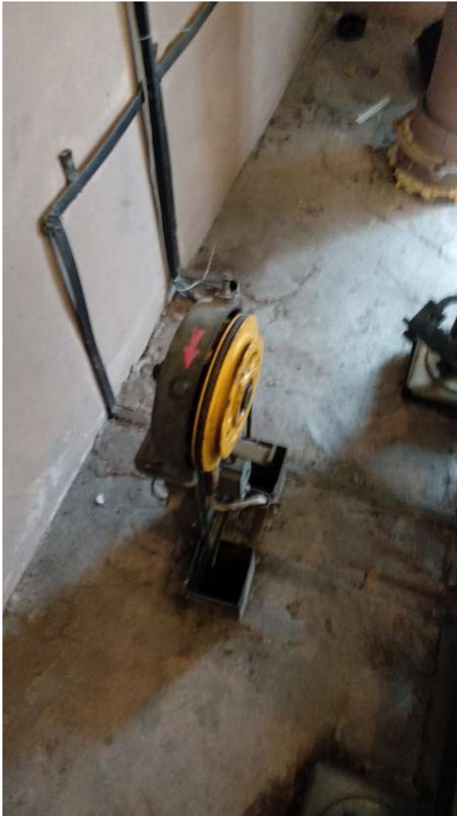
Фото 7 – Общий вид ограничителя скорости
