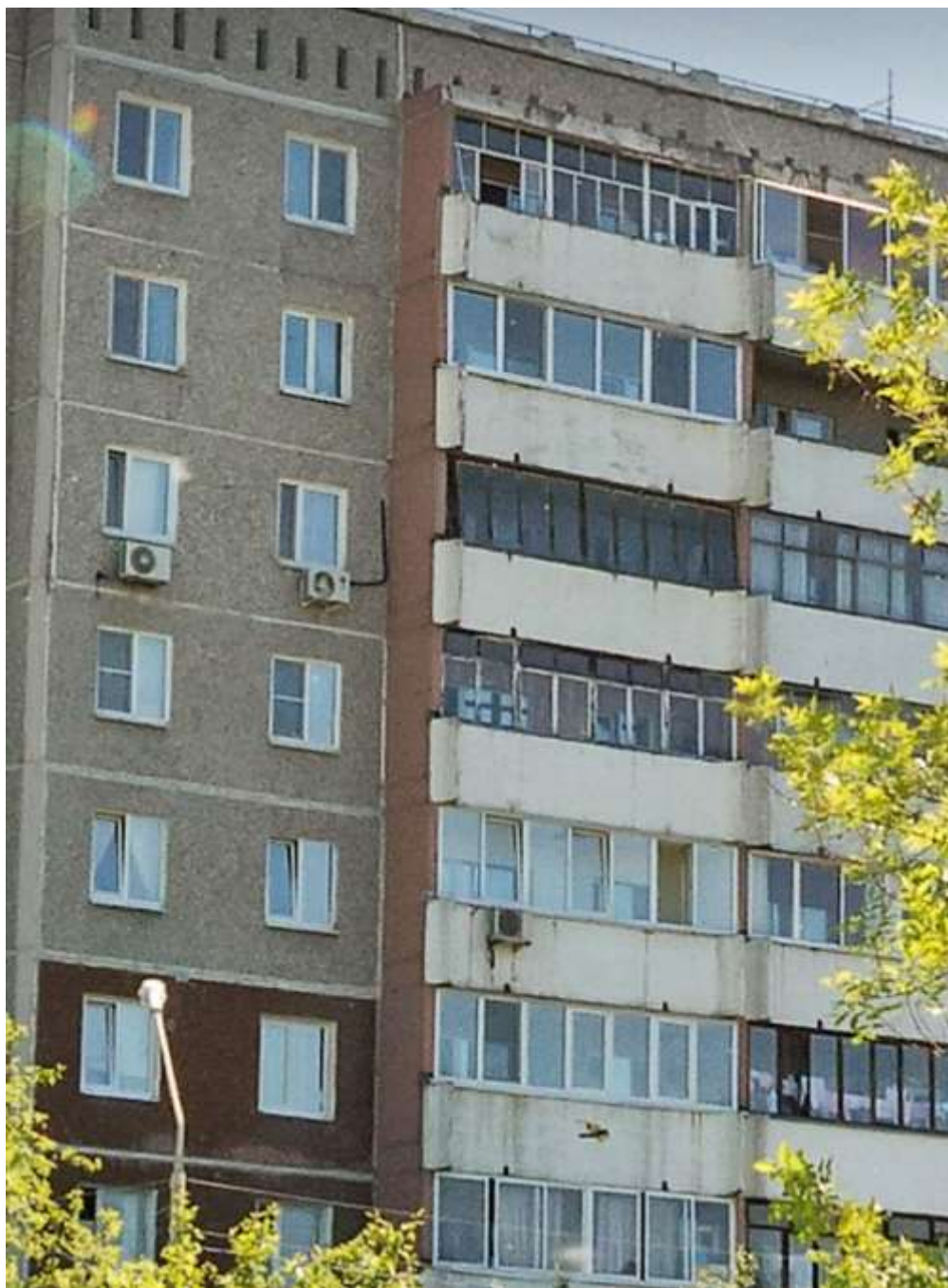
Фото 1 – Общий вид здания
