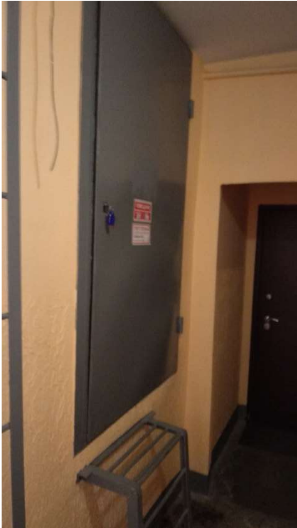
Фото 5 – Общий входа машинного помещения
