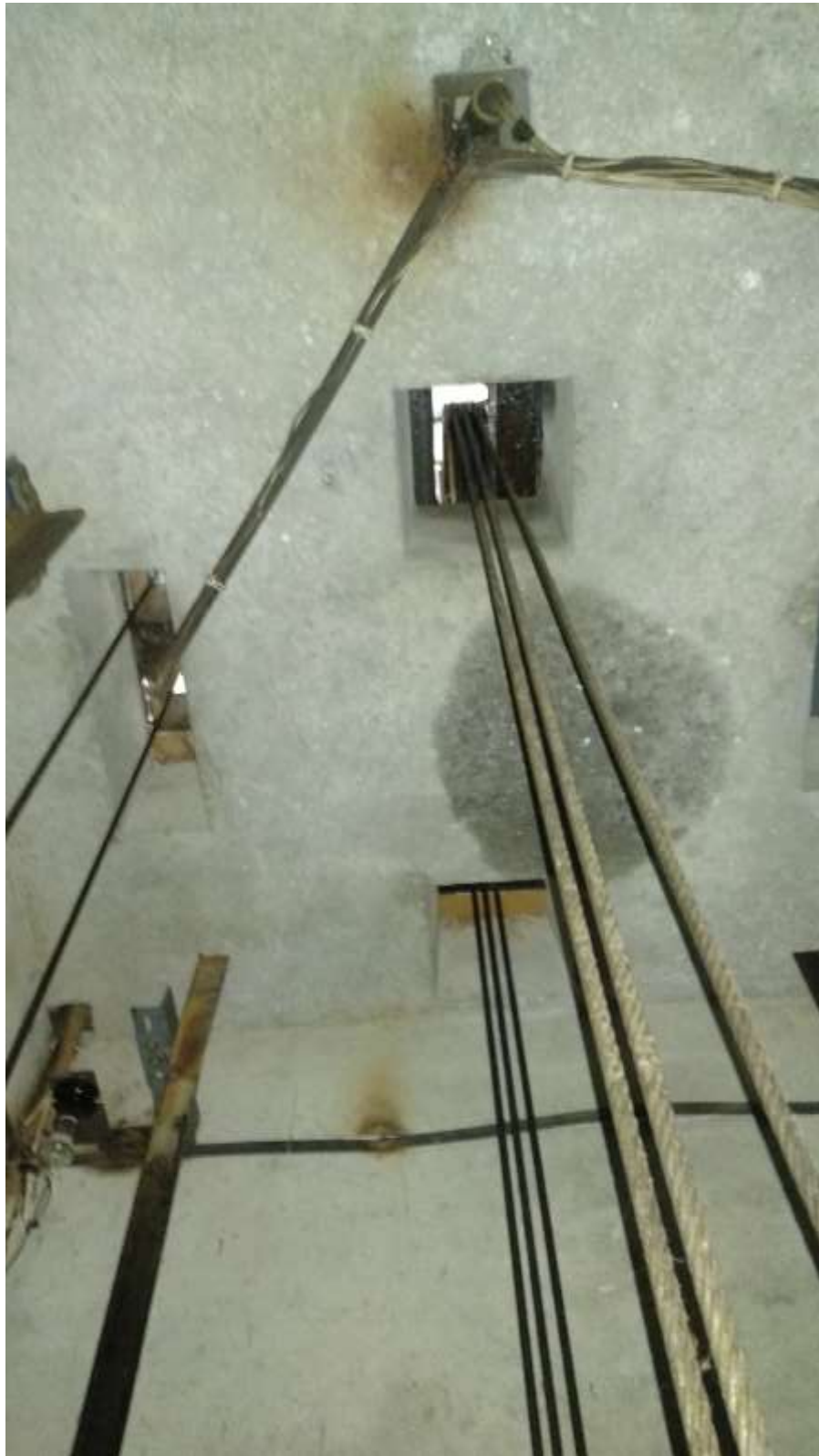
Фото 4 – Общий вид плиты перекрытия шахты
