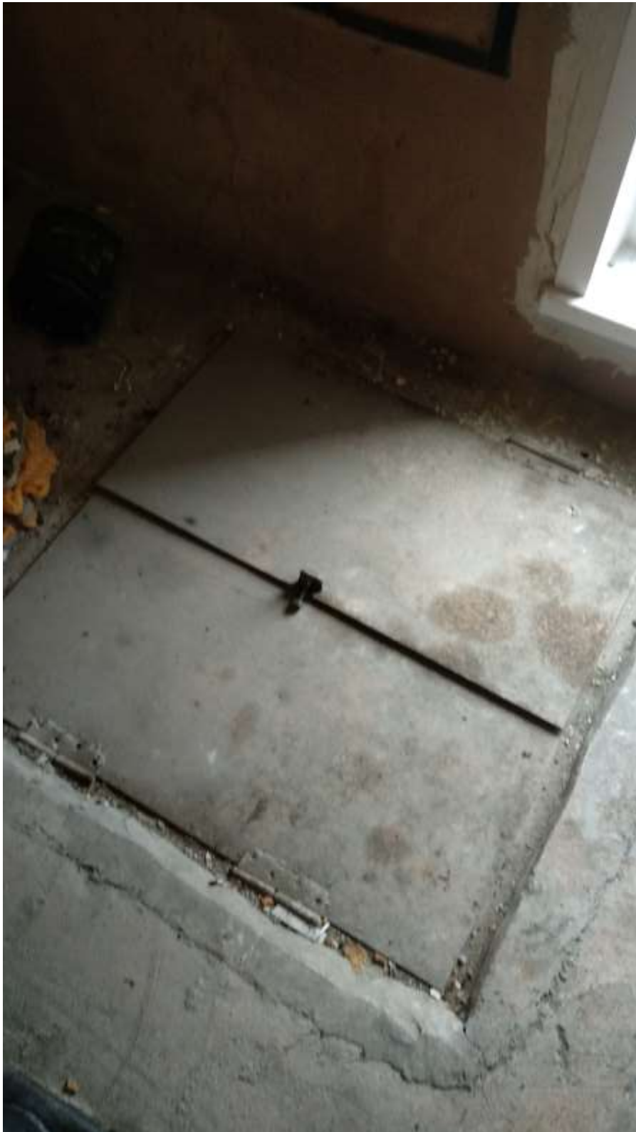
Фото 9 – Общий вид люка в машинном помещении
