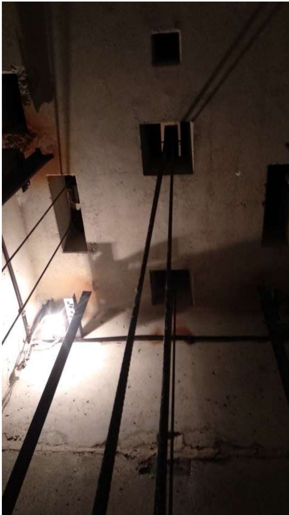
Фото 4 – Общий вид плиты перекрытия шахты
