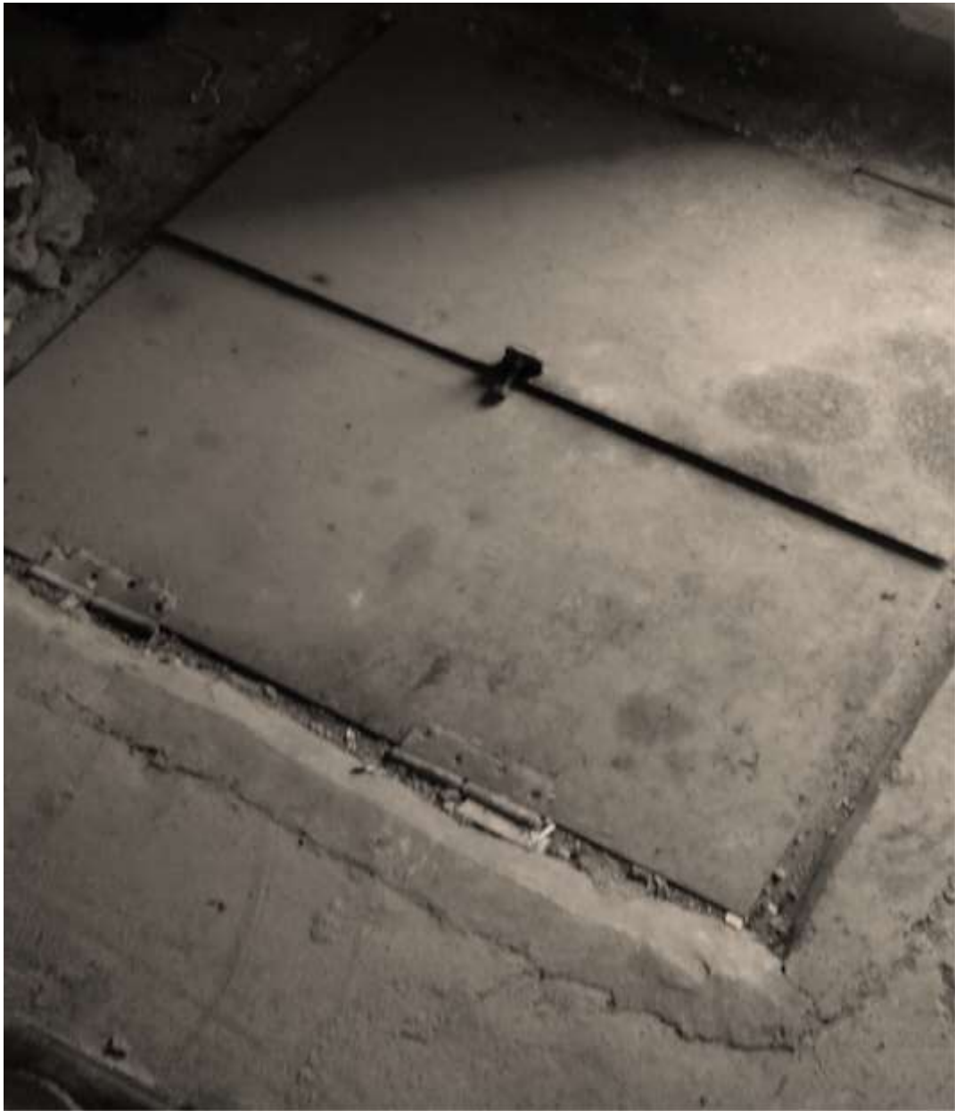
Фото 9 – Общий вид люка в машинном помещении
