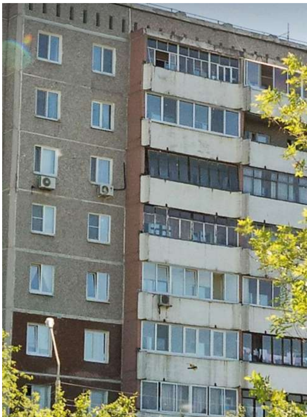
Фото 1 – Общий вид здания
