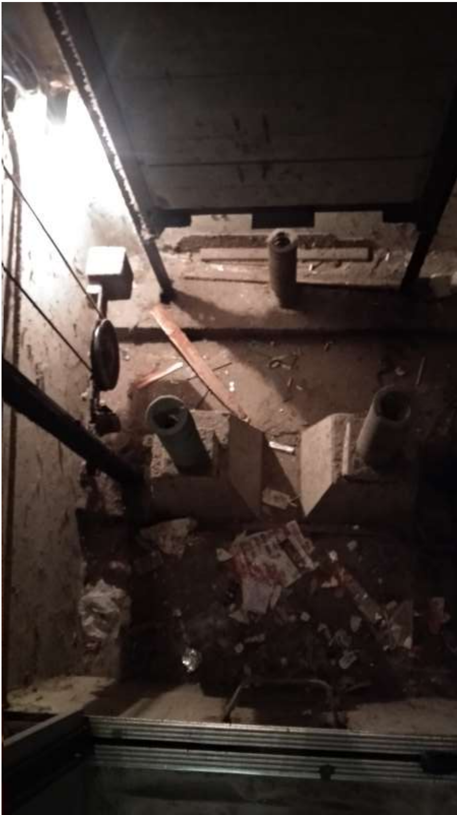
Фото 2 – Общий вид приямка
